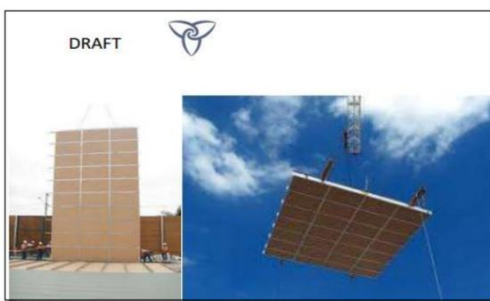
**Bioceres:** a partir de la utilización de pequeños porcentajes de rastrojos de trigo como materia prima se procede a la elaboración de paneles para construcción en seco, usando tecnología de punta, promoviendo la construcción sostenible y la valorización de un residuo agrícola.
